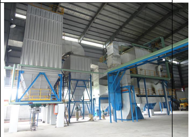
Khu nhà lò hơi mới
